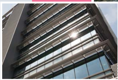
遮陽抗眩光裝置－控制陽光的直接照射
