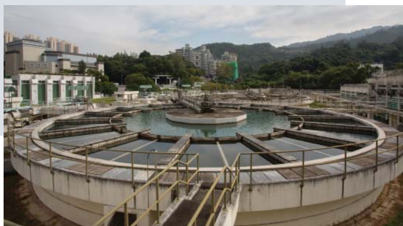
屯門濾水廠，每年可產生300萬度電
