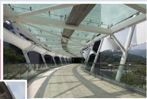
結合彩釉玻璃天幕及遮陽帳篷的行人天橋－盡量減低太陽吸熱及阻隔西斜陽光問題
