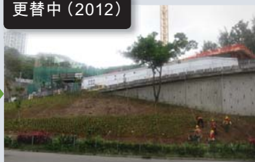
在現場進行更替種植工程
