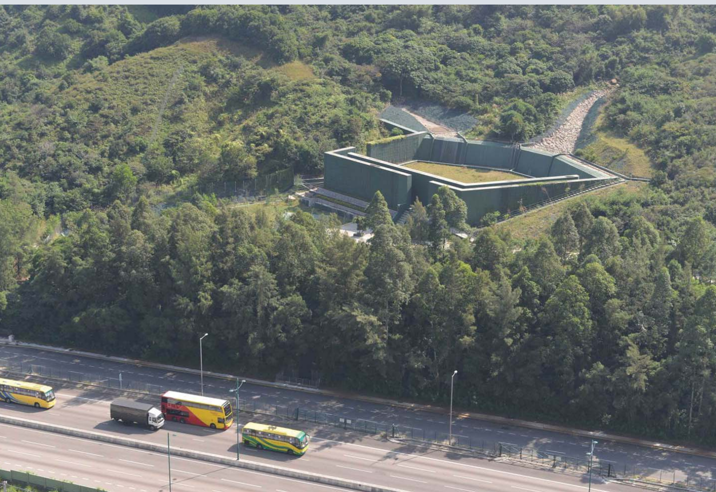
保護通往機場的主要道路（北大嶼山公路）的隔泥石屏障，防止泥石流
