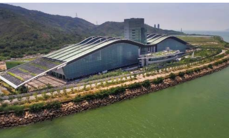
T·PARK [源·區] 污泥處理設施
