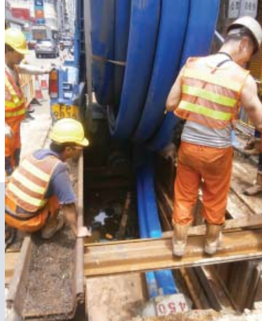
在吐露港公路進行水管修復工程
