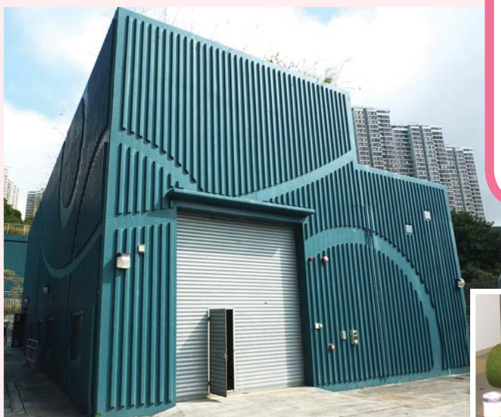
海水配水庫及高地配水系統
