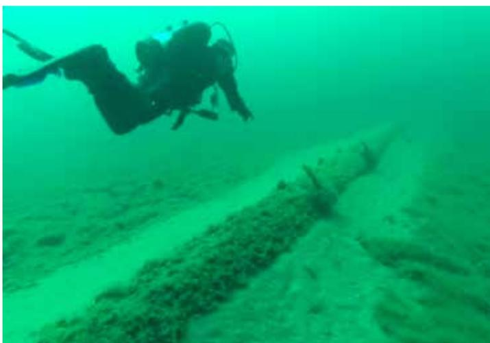
A DIVER POINTS OUT RUSTED METAL STRAPS ON LINE 5 BENEATH THE STRAITS OF MACKINAC.
